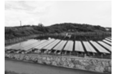
台風対策で5度に設置されている太陽光パネル
