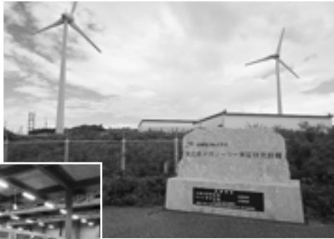
宮古島メガソーラー実証研究設備。敷地内には風力発電も設置されている
