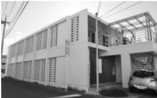
ブロック状の緩衝壁に囲まれている市街型エコハウス
