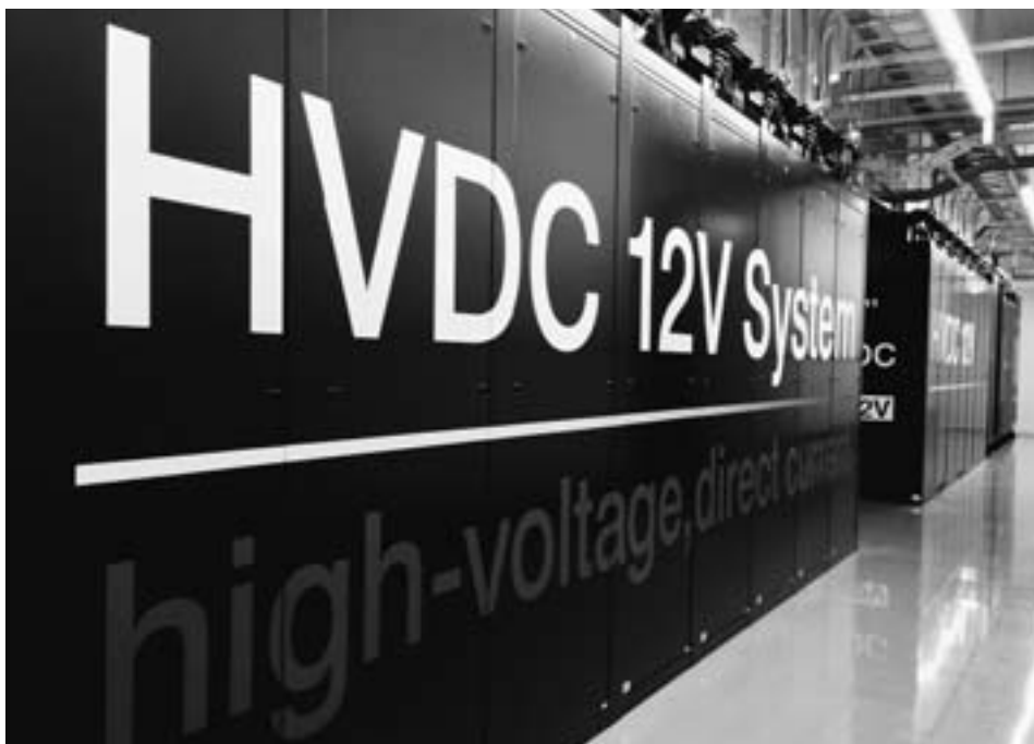
高電圧直流 (HVDC) 給電システムでは、変換が一度で済むため、電力効率が大幅に向上する
