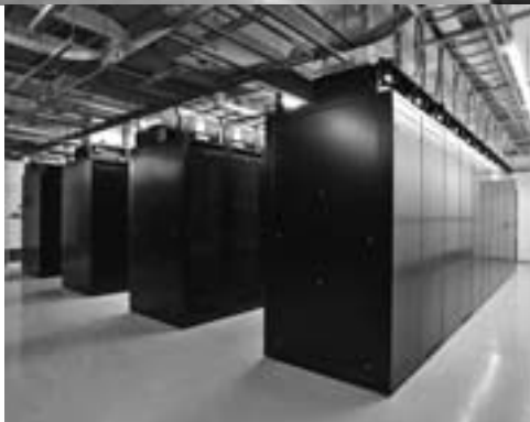
サーバールームは、外気を取り入れて冷房をしている
