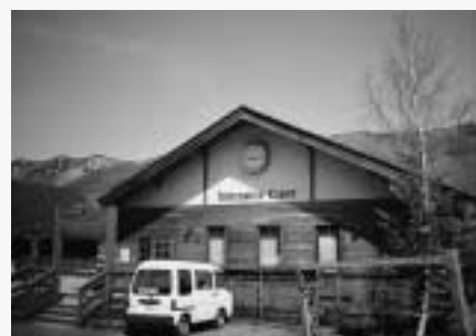
サーバー室がある「いがレクリエーションランド」のインフォメーションセンター
