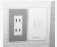
客室内のLANコンセント
