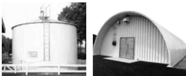
社内で換気冷房として活用しているアイスシェルターと、農産物貯蔵用のアイスシェルター
