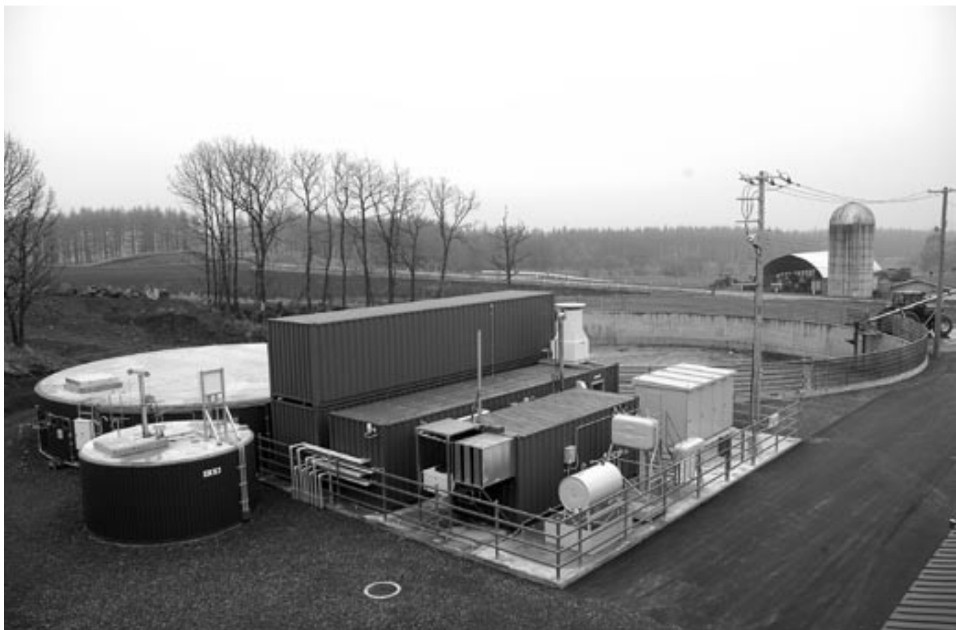
土幌に建設されたバイオガスプラント
