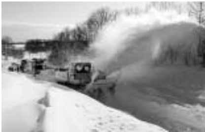
除雪状況（国道238号 湧別町）
