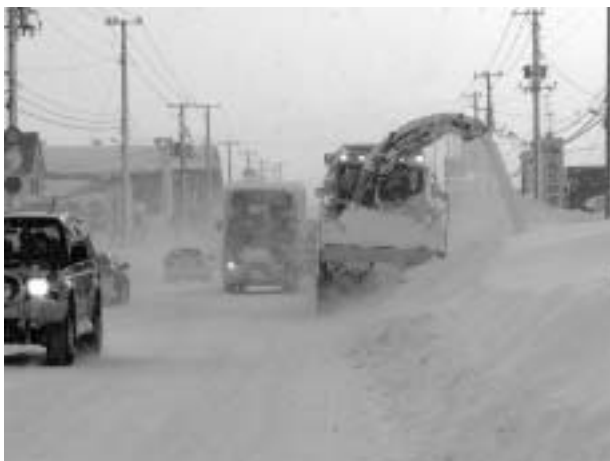
車道幅員を確保(国道39号北見市内)
