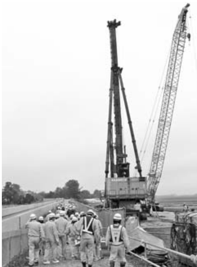
巨大なくい打ちを間近で見学
