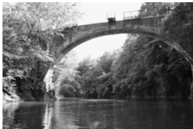
上士幌町のふるさと納税は、旧国鉄士幌線コンクリートアーチ橋の第三音更川橋梁の補修のためにも活用されている
