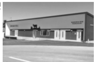
ふるさと納税の感謝特典制度で人気が高まり、新設されたドリームヒルの新工場
