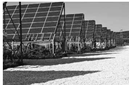
ホタテの貝殻を敷いて、発電効率を高めている
